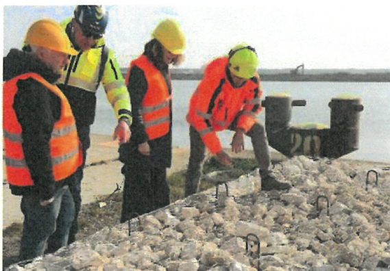
Il sopralluogo al terminal Piomboni, dov'è in costruzione il reef (Foto Corelli)
